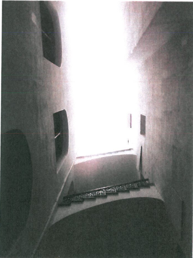
Porrashuone A / Valokuilu
